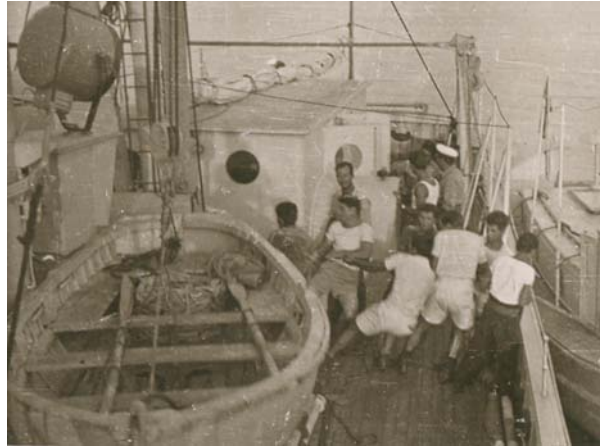
Εικ. 2 : Καθαίρεση Υ/Γ Λέμβου
